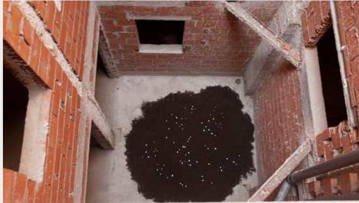
Atención: edificio (en) con obras
